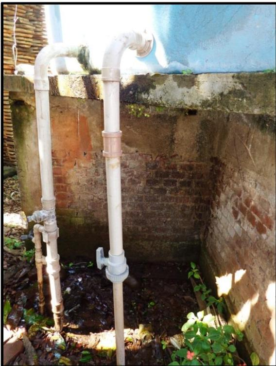
**Figura 47: Vazamentos nas tubulações do reservatório do bairro Fátima.**
