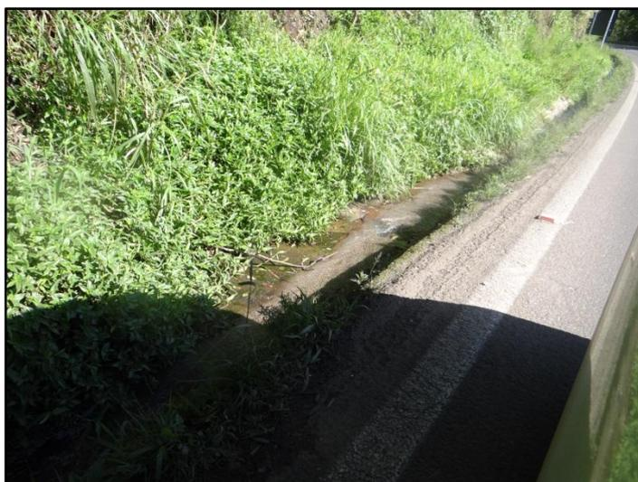
**Figura 60: Esgoto sem tratamento as margens da RS – 129**
