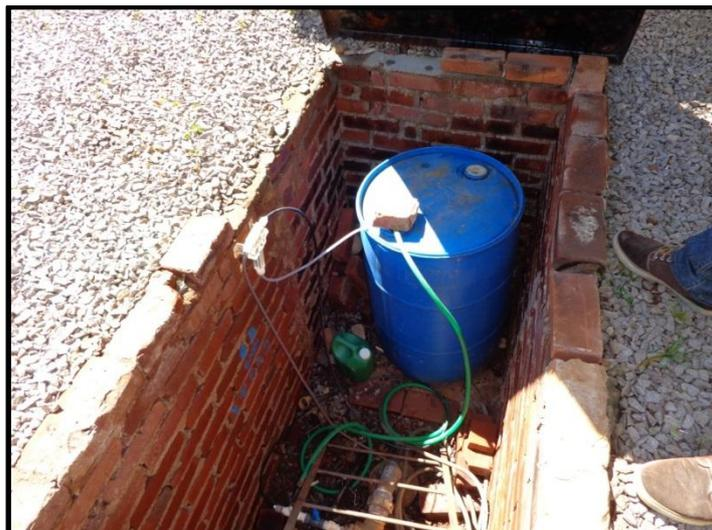
**Figura 25: Processo de tratamento por desinfecção**
