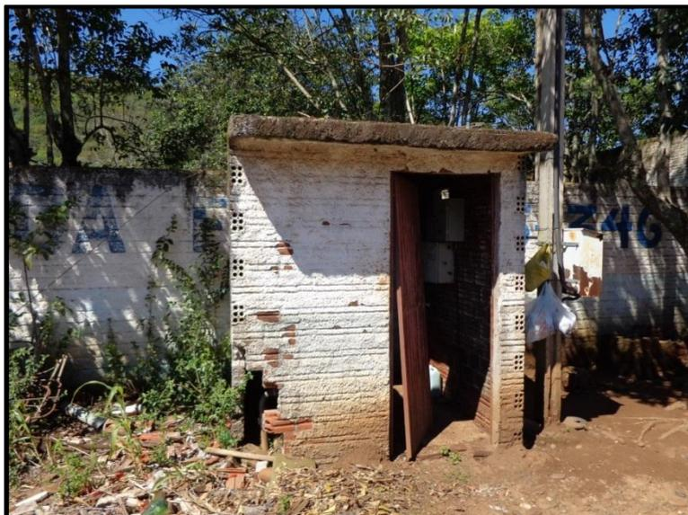
**Figura 21 - Estrutura danificada e porta sem cadeado no poço Frigorífico**
