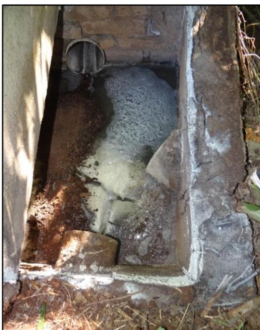
**Figura 65: Material acumulado nas caixas de inspeção da ETE.**
