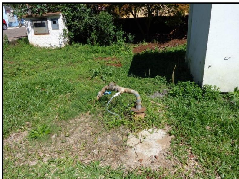
**Figura 20: Falta de manutenção por indícios de vegetação e falta de cercamento no Poço Jardim Cidade Alta.**
