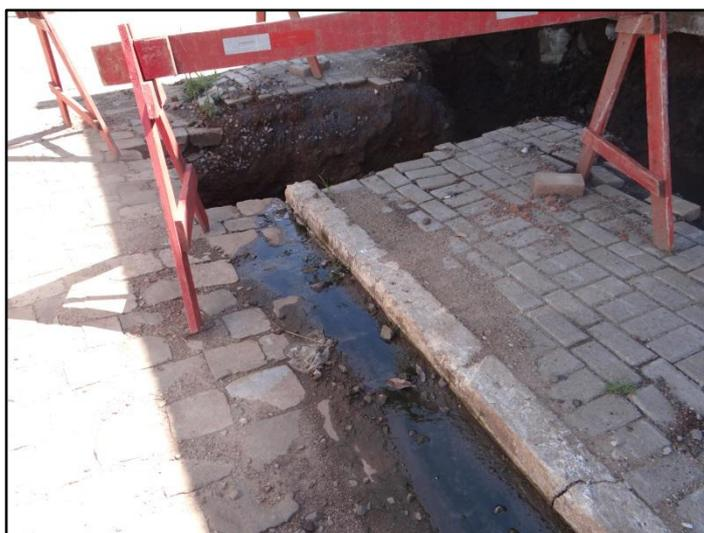
**Figura 58: Utilização das galerias pluviais para o transporte dos efluentes**
