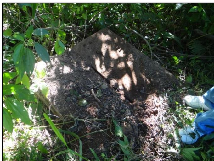
**Figura 68: Falta de manutenção é observada por indícios de vegetação**
