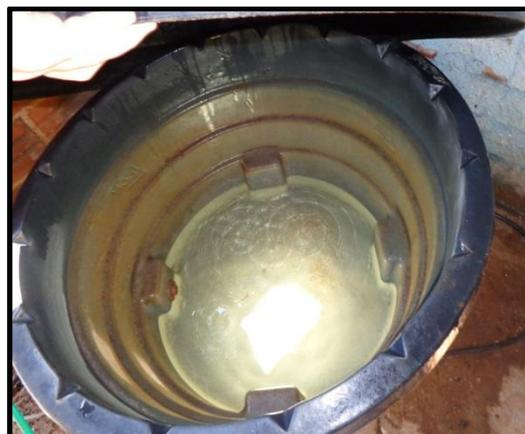
**Figura 44: Recipiente que armazena a solução de hipoclorito no Poço Frigorífico**
