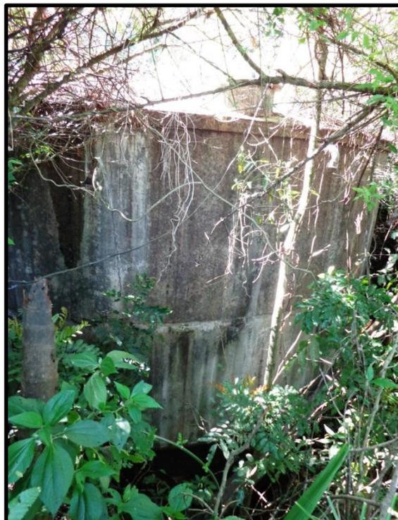
**Figura 48: Rachaduras, vazamentos e muita água acumulada no chão do reservatório Bonatto.**
